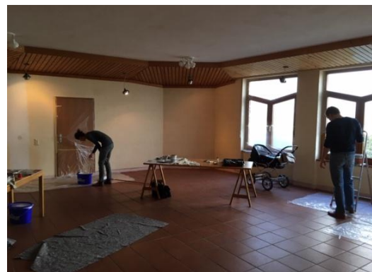
Unser Gemeinderaum wird gestrichen
