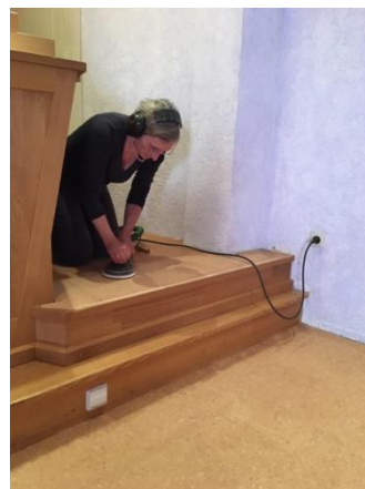
Der Emporenboden wird abgeschliffen
