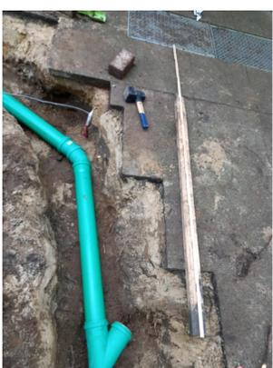
An diese Abzweigung schließen wir die Regenwasserleitungen von der südlichen und westlichen Dachhälfte an.
