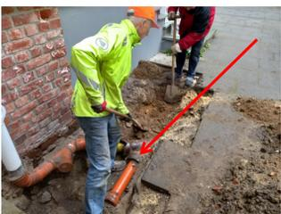
An dieses Rohr legten wir vom Regenfallrohr mit KG-Elementen und einem flexiblen gelben Rohr eine Verbindung zu diesem Rohreinlass. Zuvor hatten wir geprüft, dass Wasser immerhin langsam, aber dennoch abfließt und kein weiteres Wasser mehr in die „Hölle“ gelangte.
