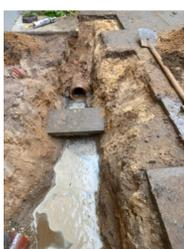
Die Abzweigung entfernten wir und prüften mit Spirale und Wasserschlauch, ob und wie weit das alte Tonrohr zugesetzt war. Leider war es zugesetzt und das Wasser lief zurück in die Grube. So arbeiteten wir uns Rohrstück für Rohrstück voran...
