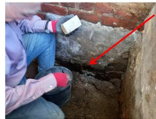
Durch dieses Loch in der Außenwand und ein wesentlich größeres in der Innenwand gelangte das Regenwasser aus dem defekten Tonrohr in die „Hölle“ und damit in den Kellerflur.
