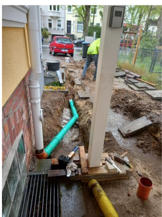
Nach dem Ausnivellieren des Gefälles der Rohre füllten wir die Gräben auf.
